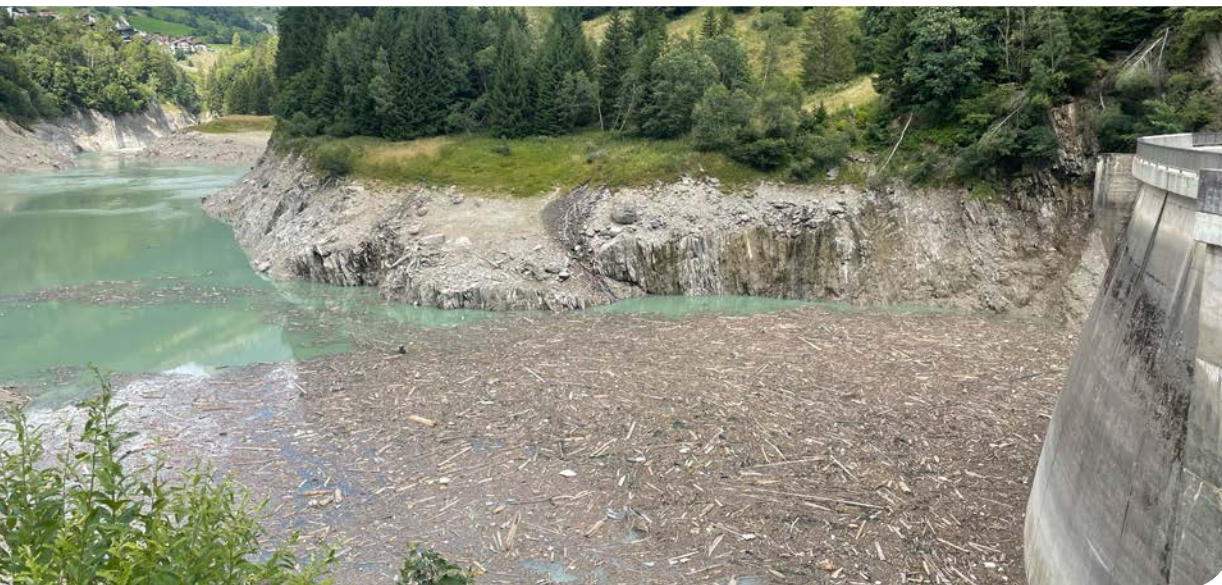
↑ Geschwemmsel des Stausees in Lötschen in der Schweiz nach dem Bergsturz in Blatten.
