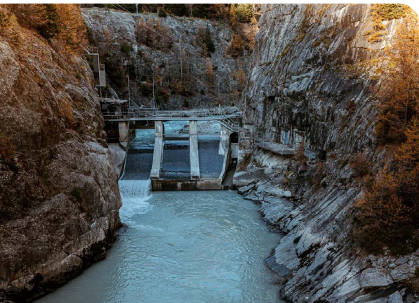
↑ Wasserfassung Aletschji des Kraftwerks Mörel
