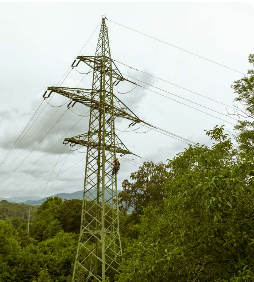
↑ Netzmonteur bei der Arbeit
