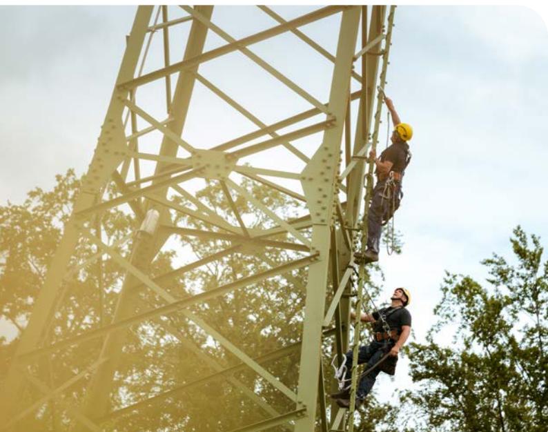
↑ Netzmonteure der naturenergie netze GmbH bei der Arbeit
